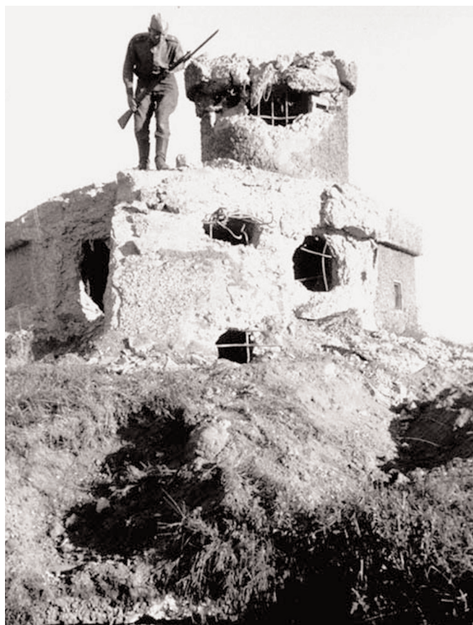
Разрушенный японский дот Хайларского укрепленного района. Забайкалье
