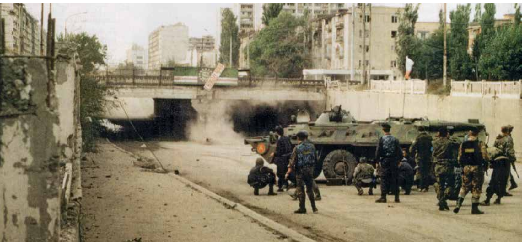
Тоннель возле площади Минутка в Грозном. 1995 г.
