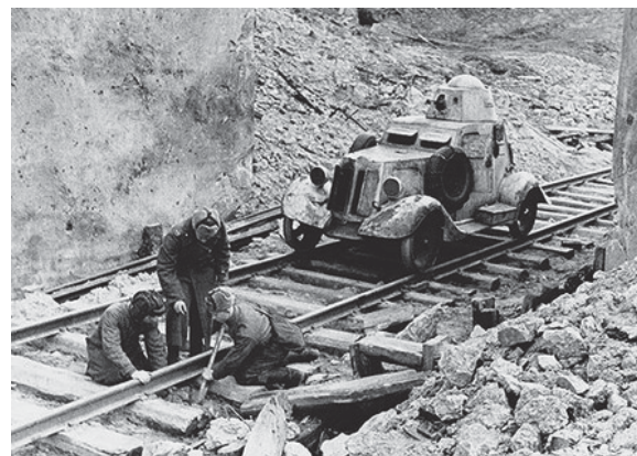
Экипаж бронемашин за ремонтом железнодорожного полотна
