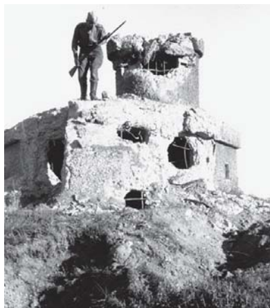
Разрушенный японский дот Хайларского укрепленного района. Забайкалье. 1945 г.
