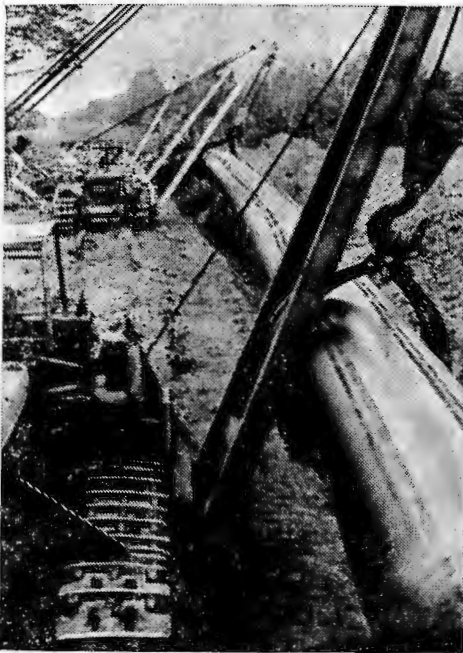
Идет строительство нефтепровода.
