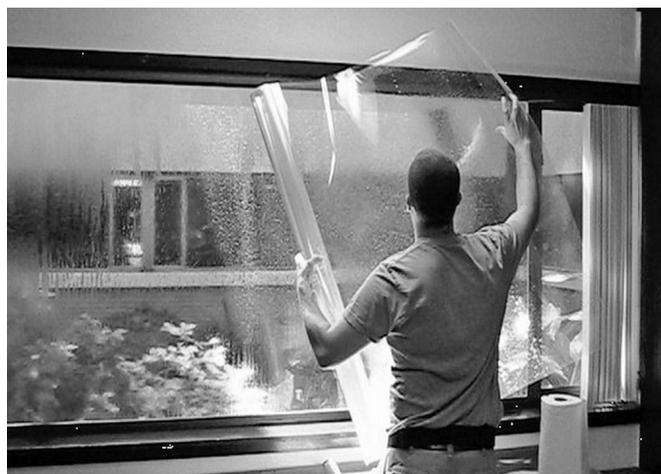
**Рис. 4. Монтаж защитной полимерной пленки**
