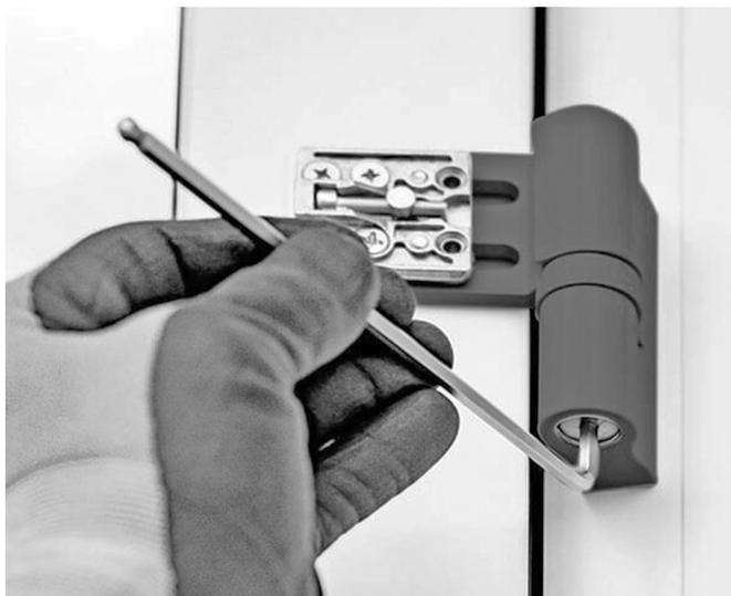
**Рис. 6. Конструкция усиленных петель с возможностью их регулировки**
