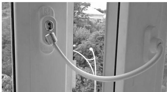
Рис. 10 б. Защитная ограничительная цепочка с замком
