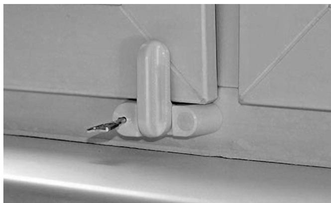
Рис. 10 а. Замок-фиксатор
