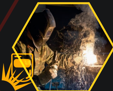
Участок сварочных работ
